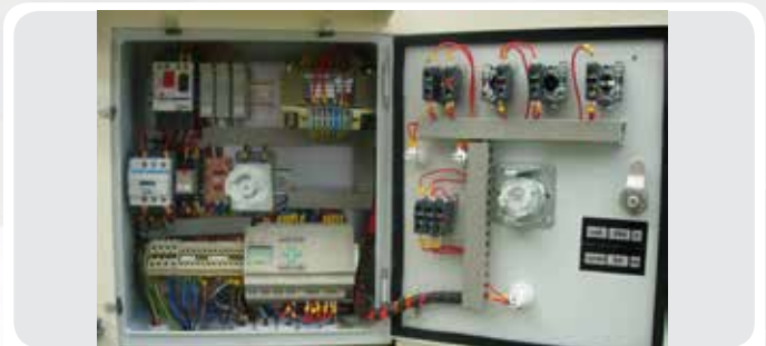
Cuadro eléctrico con elementos de protección y mando integrados
